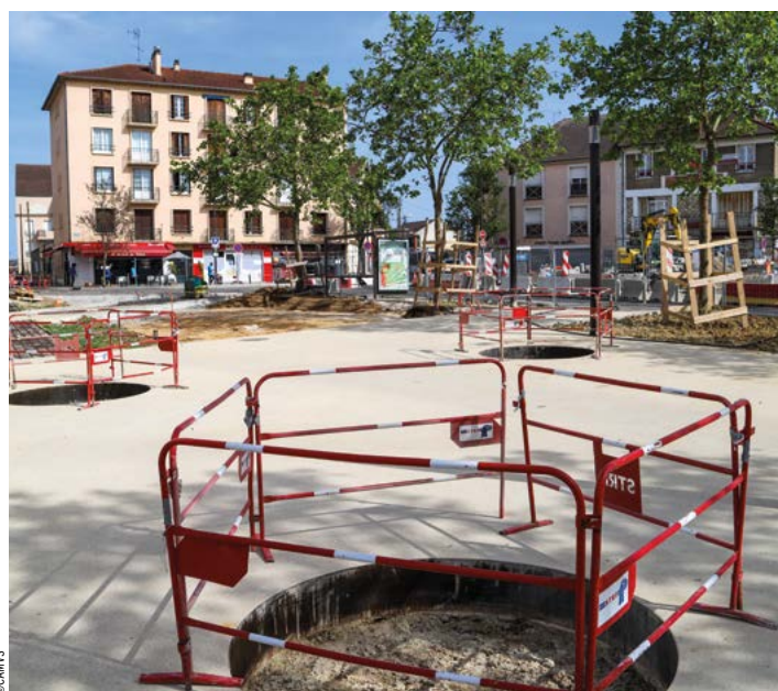
Au premier plan, les trous de plantation des futurs arbres.
