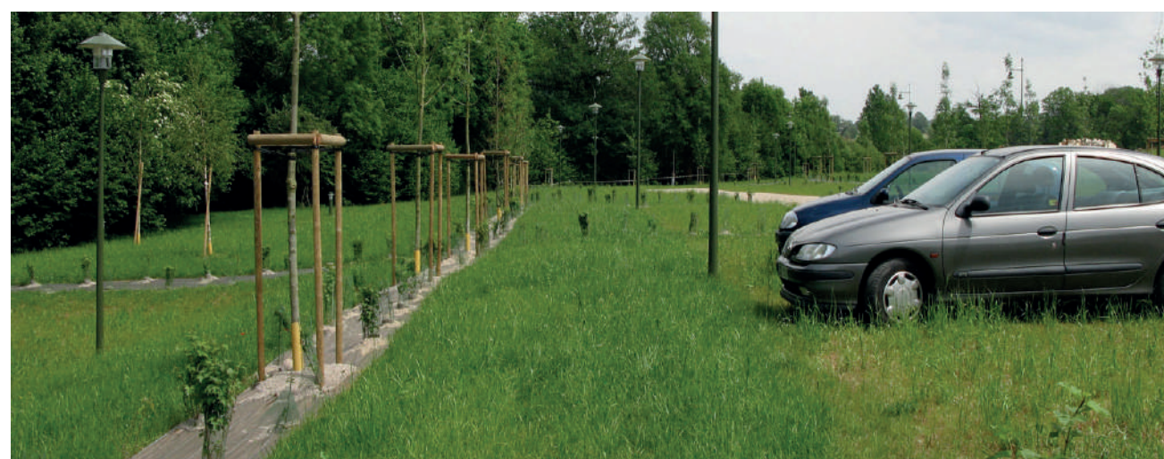
Parking sur prairie renforcée (engazonnement sur mélange terre-pierre compacté) adapté à du stationnement ponctuel
