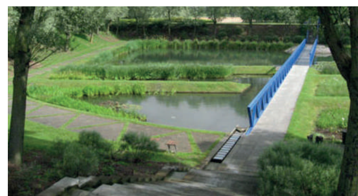
Bassin végétalisé de stockage des eaux pluviales
