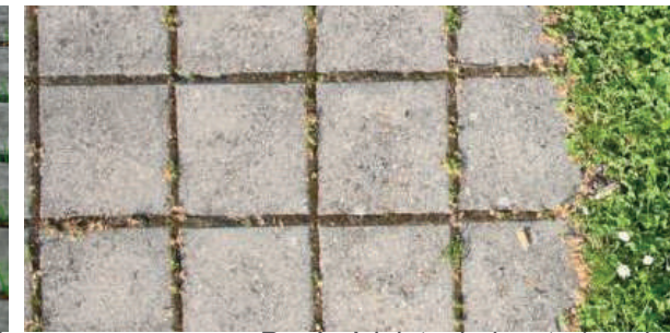
Pavés à joints drainants (gravier)
