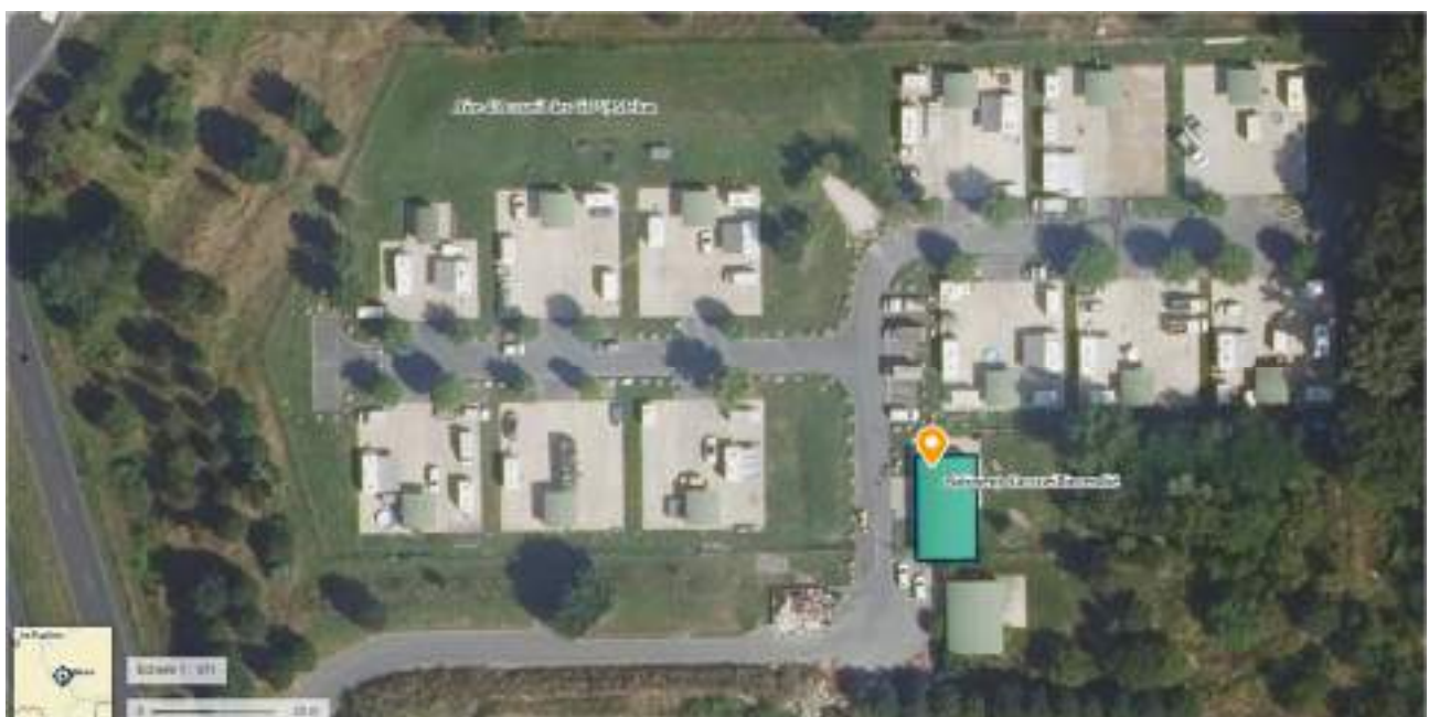
Figure 2 : localisation du local d'accueil incendié, Aire d'Accueil des GDV, Melun
