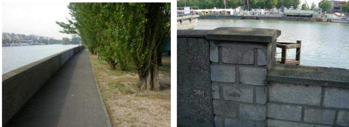
Figure 20 : Murette anti-crues dans le département des Hauts de Seine. Source : CD 92
