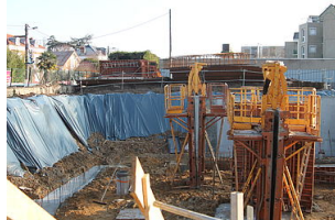
La construction de logements
